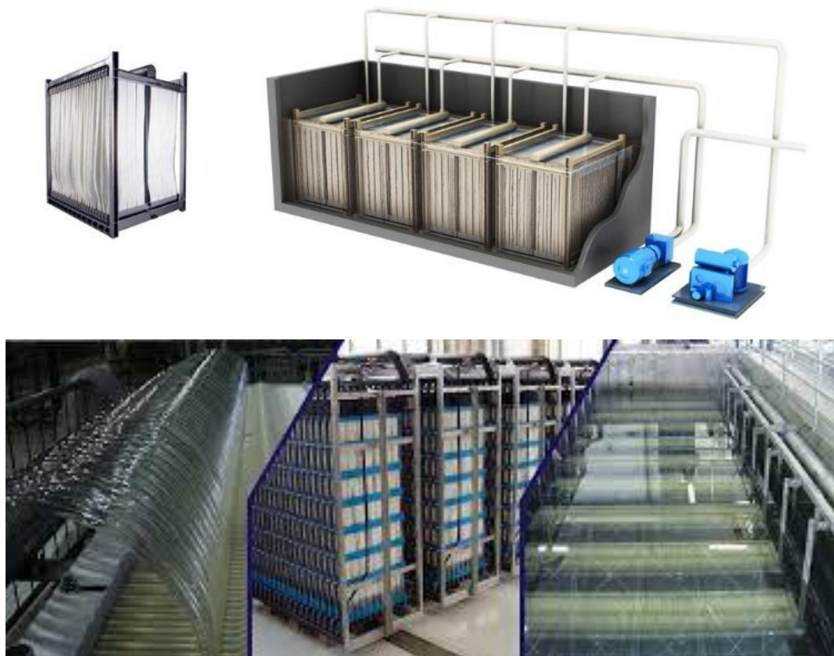
شکل ۱- نمونه از بیوراكتور غشایی مورد استفاده در تصفیه فاضلاب [۱۱]
